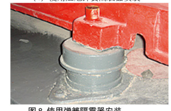
图 8 使用弹簧隔震器安装
