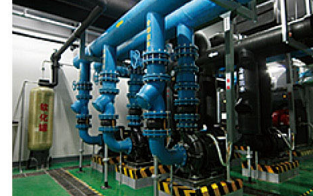
图 4 使用减震垫安装
