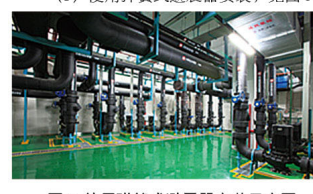
图 5 使用弹簧式避震器安装示意图
