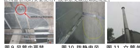
图 9 风管内严禁其他管线的穿越
