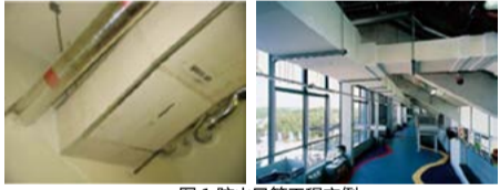
图 1 防火风管工程实例
