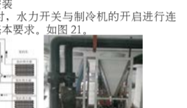
图 21 空气源热泵机组安装
