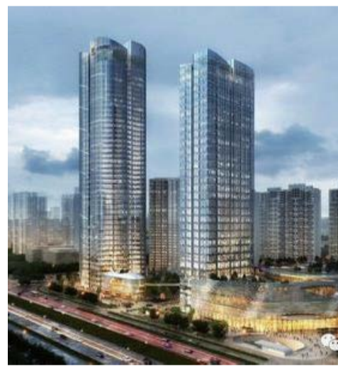
南京德基世贸中心项目
